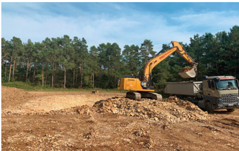
Aushub der Versickerungsmulde auf dem Gelände des Flugplatzes Aalen-Elchingen, deren Randbepflanzung mit dem Preisgeld gefördert wird
