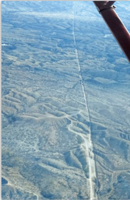
Grenze USA-Mexico: noch ein Zaun oder schon eine Mauer?
